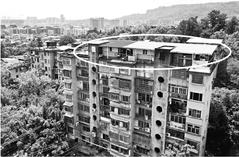
天台上搭盖了多个铁皮屋
