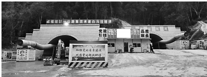
A1合同段白马埕隧道顺利贯通
