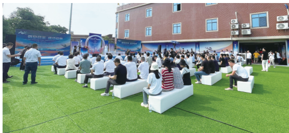
南安城市空中交通运营中心项目开工
