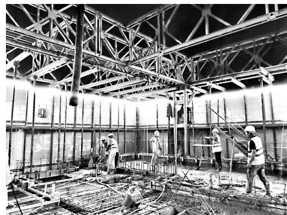
工人在“住宅造楼机”里施工
