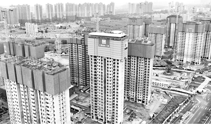
“住宅造楼机”所在楼栋主体结构封顶
