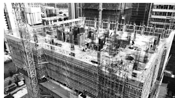
高新区物联网设备生产基地施工现场
