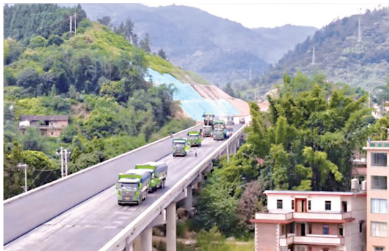
该项目全面进入路面施工阶段
