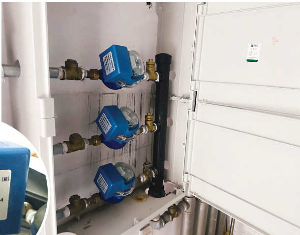
改造后的水表增加了“无线摄像表传感器”
