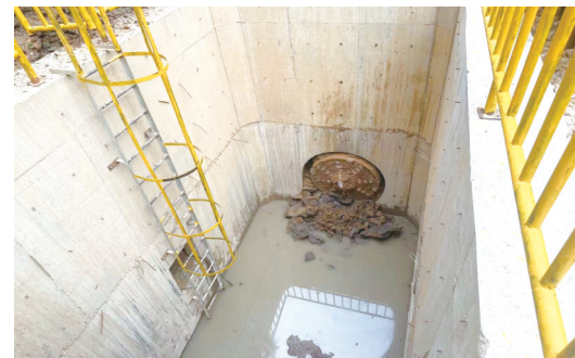
顶管施工管道穿越至接收井
