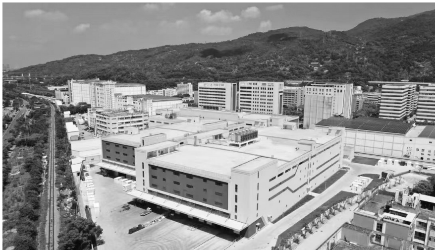
福州马尾智能化新能源装备及智慧储能装备制造项目现场
