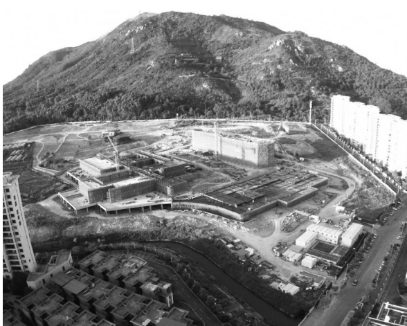
建设中的安踏学园
