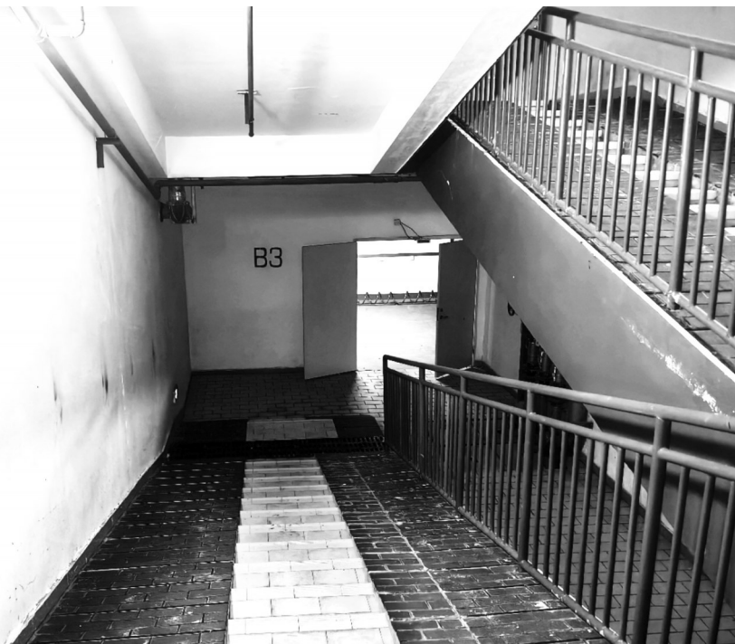
地库入口设计为坡道加台阶,业主称电动车上下不方便
