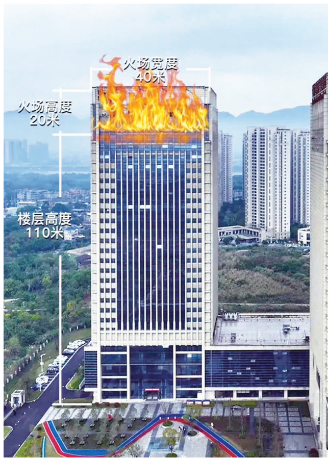
高层消防展演现场,火场总高130米、过火面积500平方米
