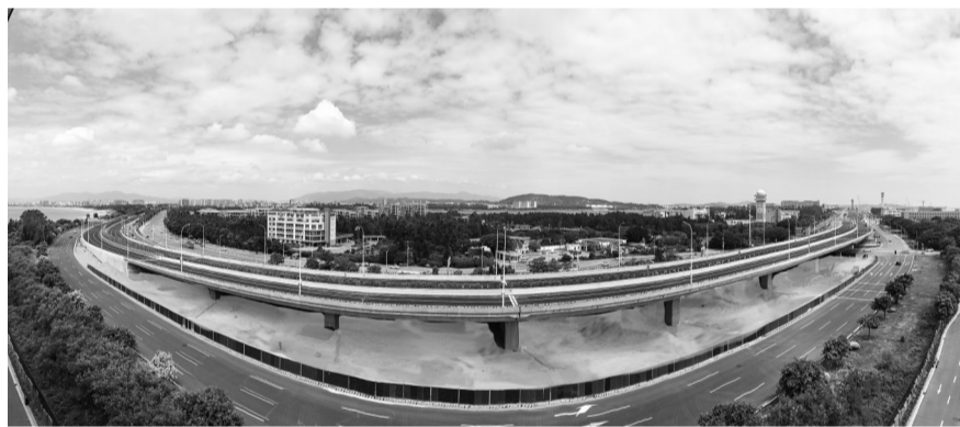
南进场路主线顺利通车
