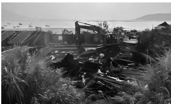
拆除大埕沙滩旁边的非法虾塘
