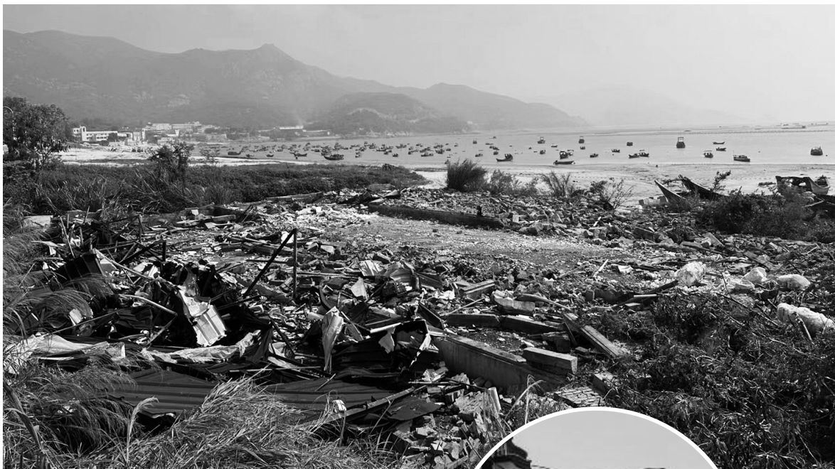
非法虾塘全部被拆除
