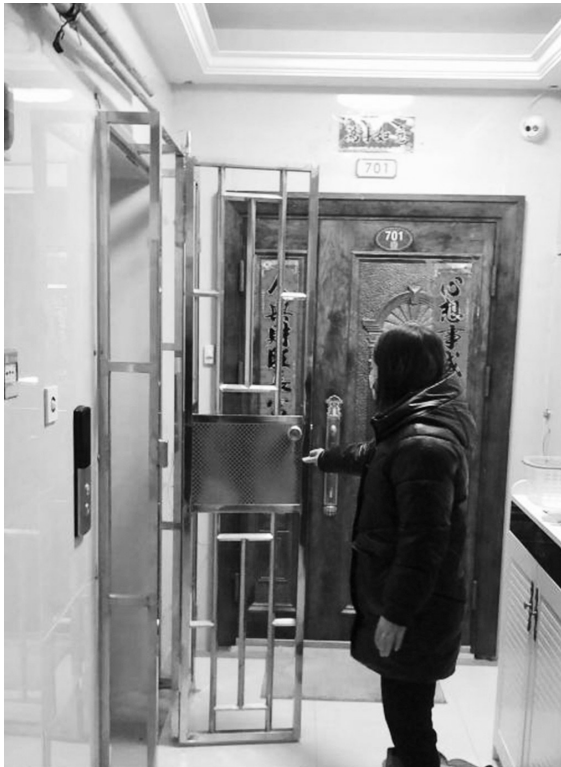
敖江镇拆除电梯口违建的不锈钢门
