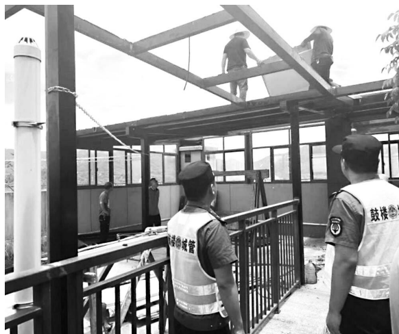
五凤城管中队组织工人拆除楼顶违建
