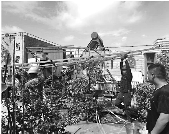
鼓东城管中队组织工人拆除楼顶违建
