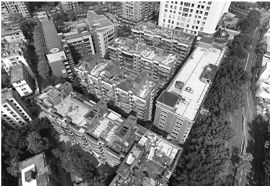
温泉街道某小区楼顶违建被统一拆除
