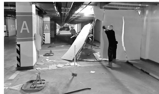
拆除地下停车场违建
