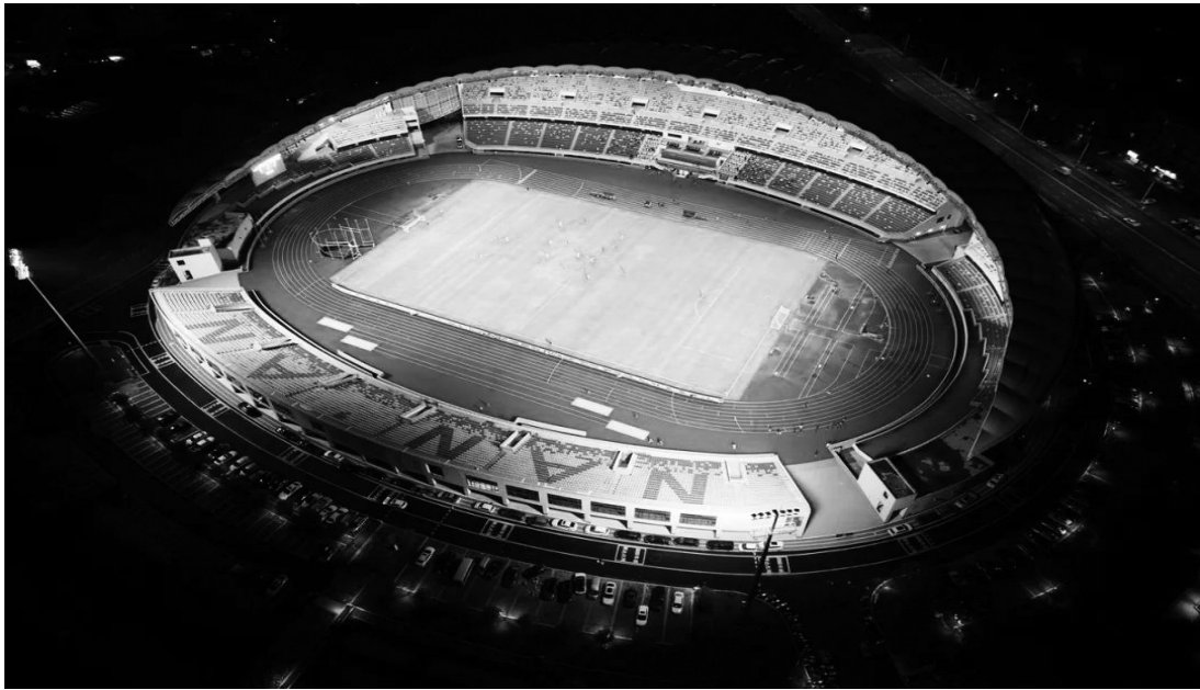
已经启用的南安市新体育场
