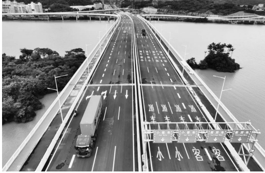
通车后的武荣大桥
