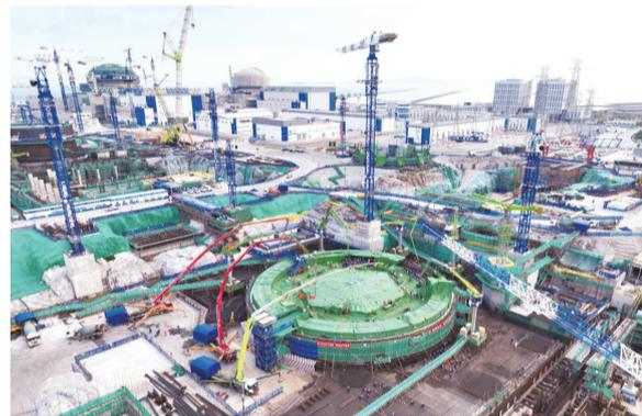
27日,中核集团漳州核电二期工程4号机组浇灌核岛第一罐混凝土现场(新华社/图)
