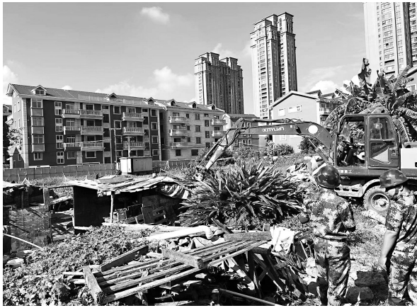
阳下街道奎岭新村拆除违建鸡鸭舍
