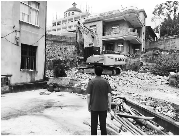
城头镇五龙村拆除违建
