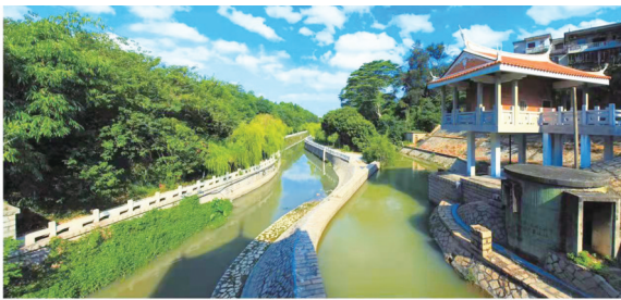
北渠环城桥水闸渠段改造前后
