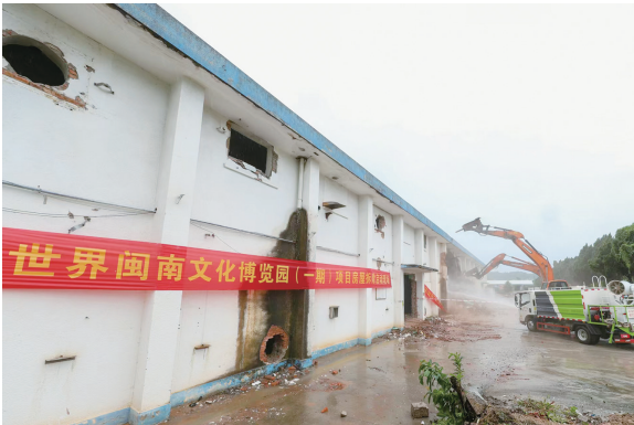
世界闽南文化博览园(一期)项目启动房屋拆除工作(王志超/摄)
