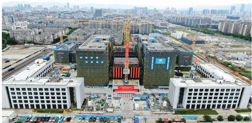
海都讯(记者 周婉怡 唐明亮/文 毛朝青/图) 9月29日,一场高难度的“提升”行动,在位于仓山区南台大道与双湖路交叉路口的市公安局技术用房项目现场展开,重达1500吨的楼体空中连廊钢结构桁架,在无人现场施工的情景下,历时6个小时,成功提升到了45米的高度。
