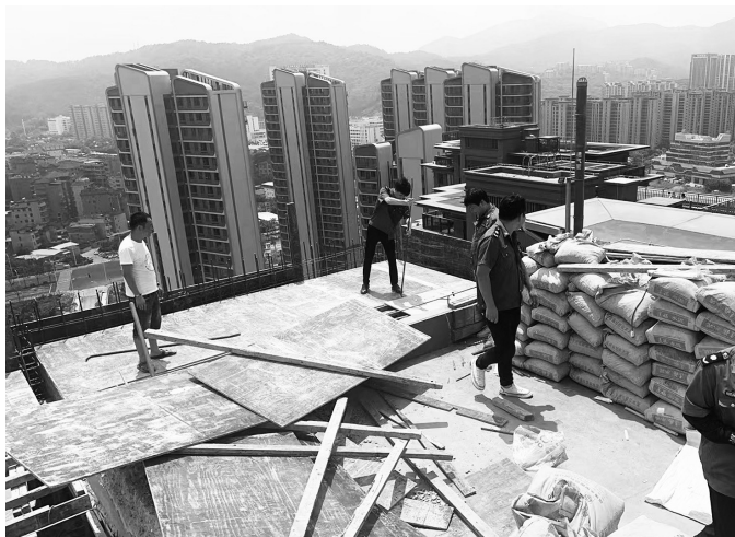
航城一小区顶楼违建被拆除
