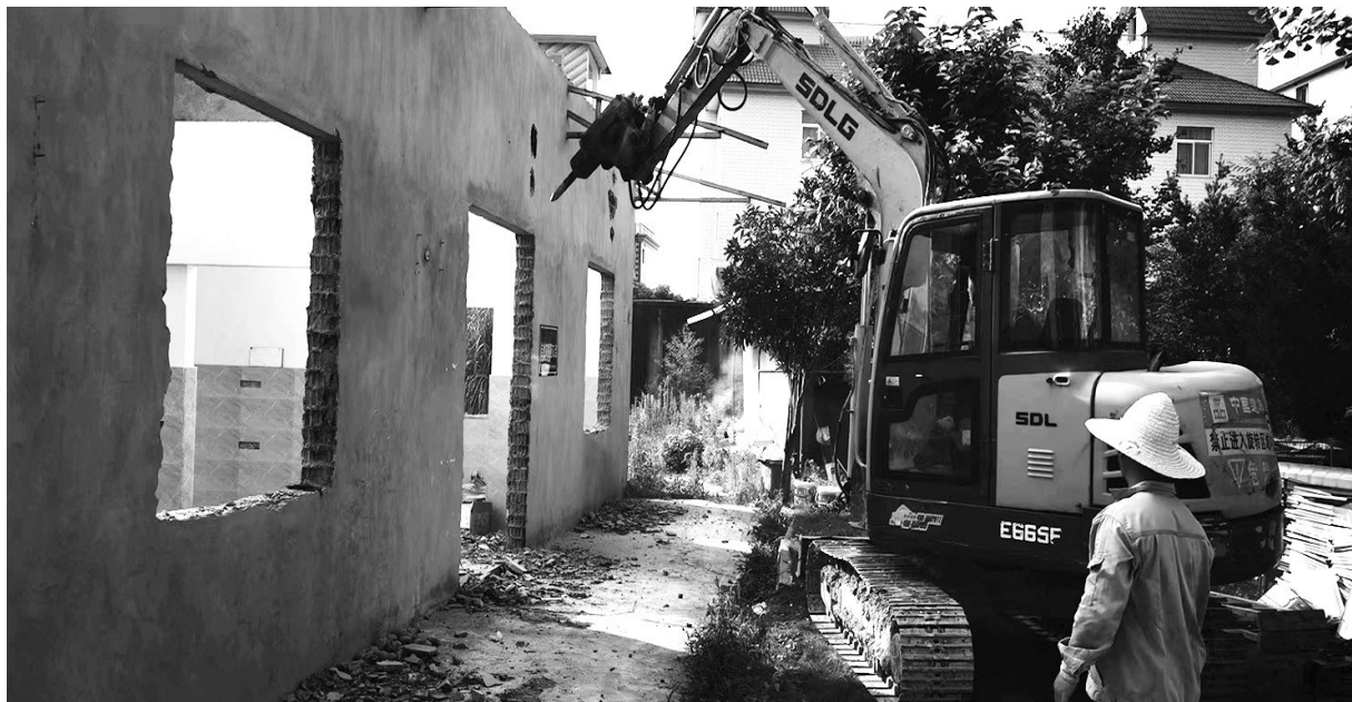
拆除玉田镇一处违建房屋
