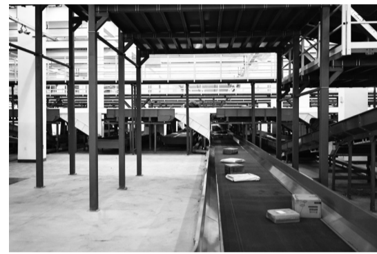
中通快递福州转运中心一期已投用(连融媒供图)
