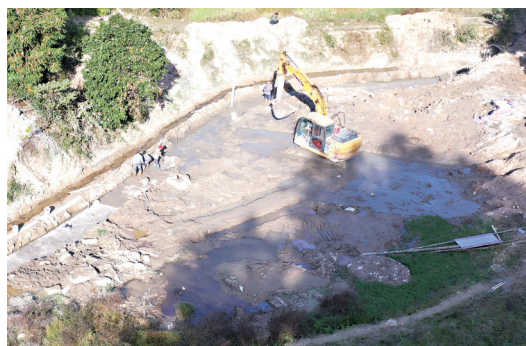
溪水源头附近一处工程正在施工
