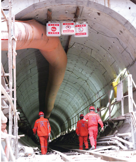
4号线一区间隧道全线贯通
