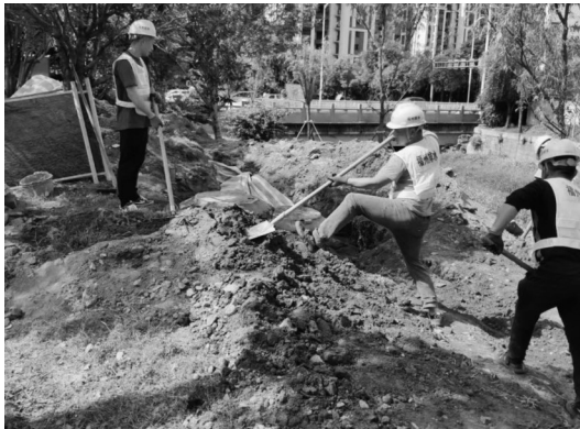
施工人员正在开挖沟槽(吕仕杰/摄)
