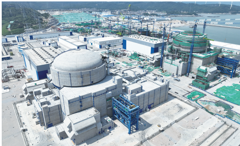
正在建设的漳州核电二期工程
