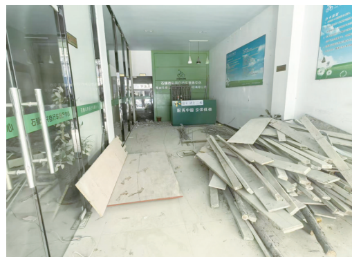
室内堆满建筑材料
