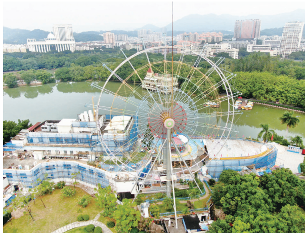
左海摩天轮正在拆除
