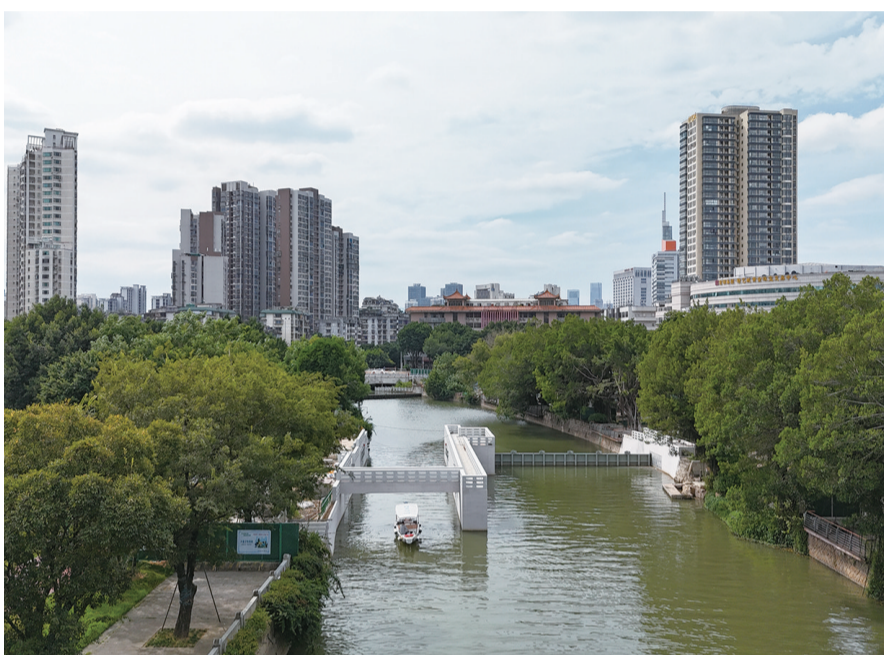
光明港船闸主体工程已完工投用 (均为福州市水务文旅公司供图)
