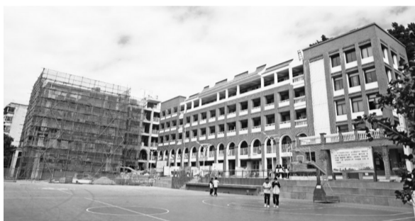
教学楼外墙采用闽南传统建筑特色的红砖
