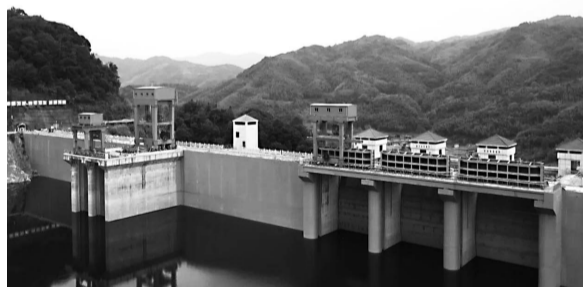
霍口水库工程大坝(部门供图)
