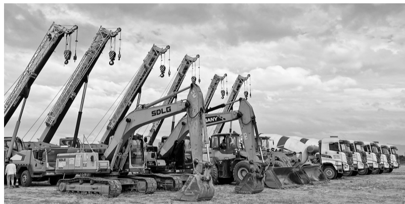
项目开工现场(游斐渊 陈逸帆图)
