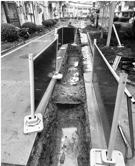
博雅星城雅园小区正在进行供水管道改造
