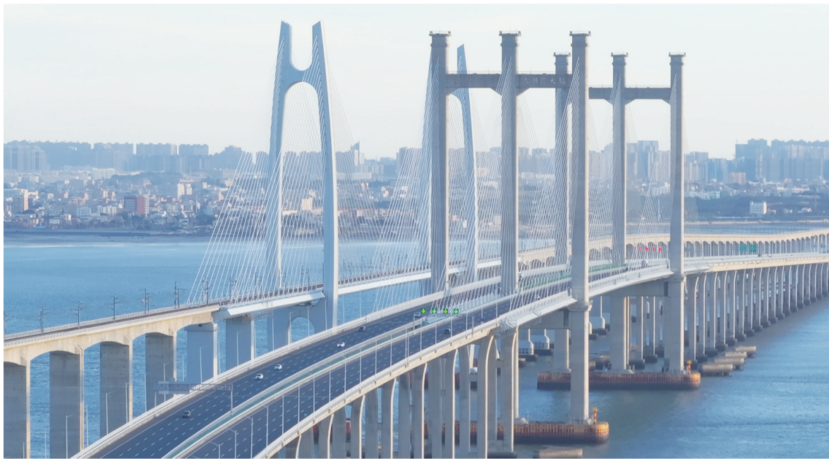
记者早前拍摄的泉州湾跨海大桥车流情况
