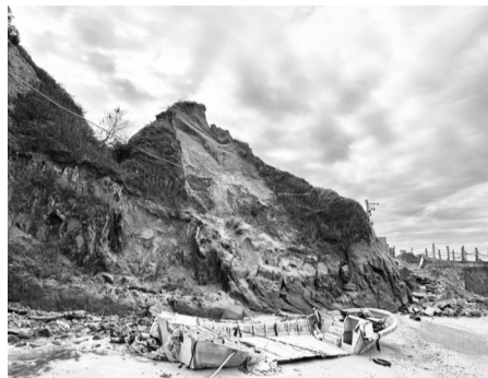
▲坍塌后,“海坛大佛”造型不复存在
