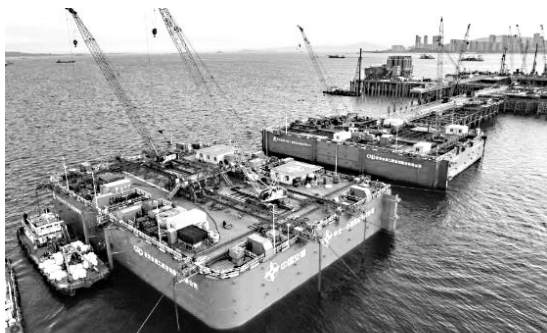
正在施工的刘五店航道桥
