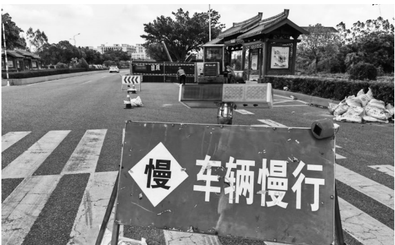
施工现场加装安全防护措施
