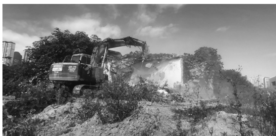
拆除一处违法建设房屋
