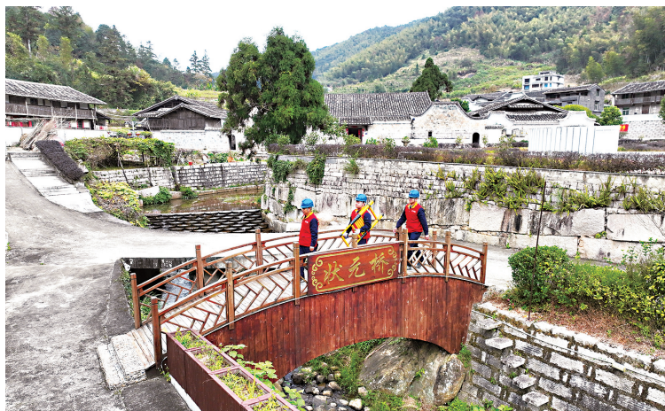
国网福州供电公司工作人员在罗源县西兰乡洋坪村对村里古厝的供电设施开展安全用电检查
