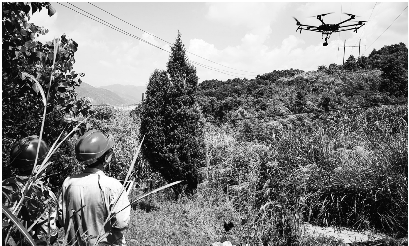
福建榕能电业集团有限公司运维保障人员在琅岐开展配网无人机巡检
