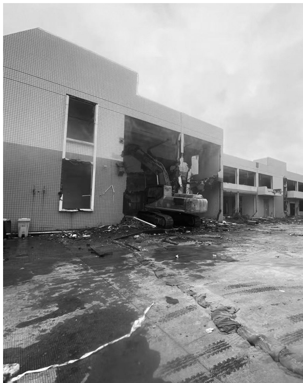
马尾镇一处违建房屋被拆除
