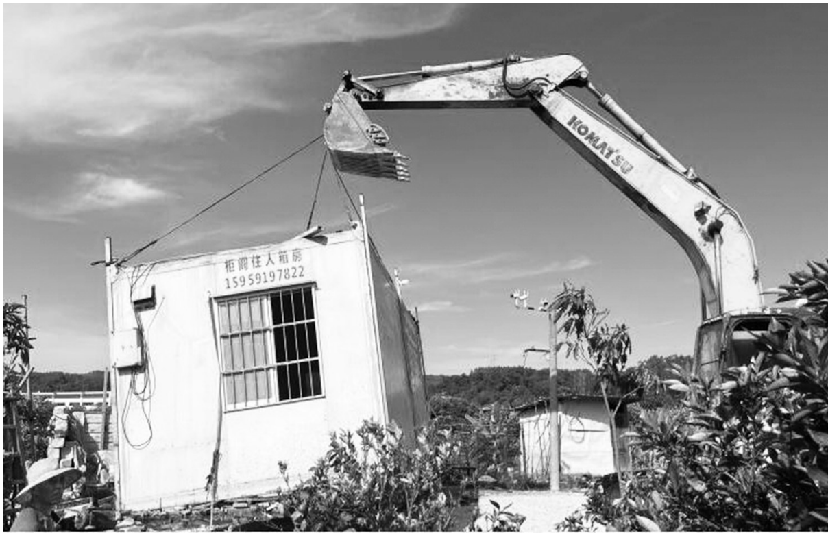
琅岐镇拆违现场
