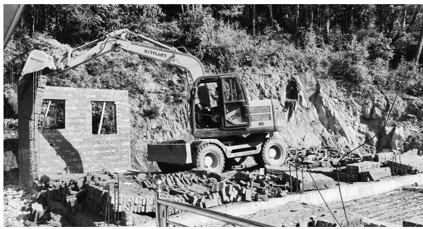
亭江镇白眉村违建被拆除
