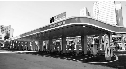
育成基地的光储充检超级充电站
