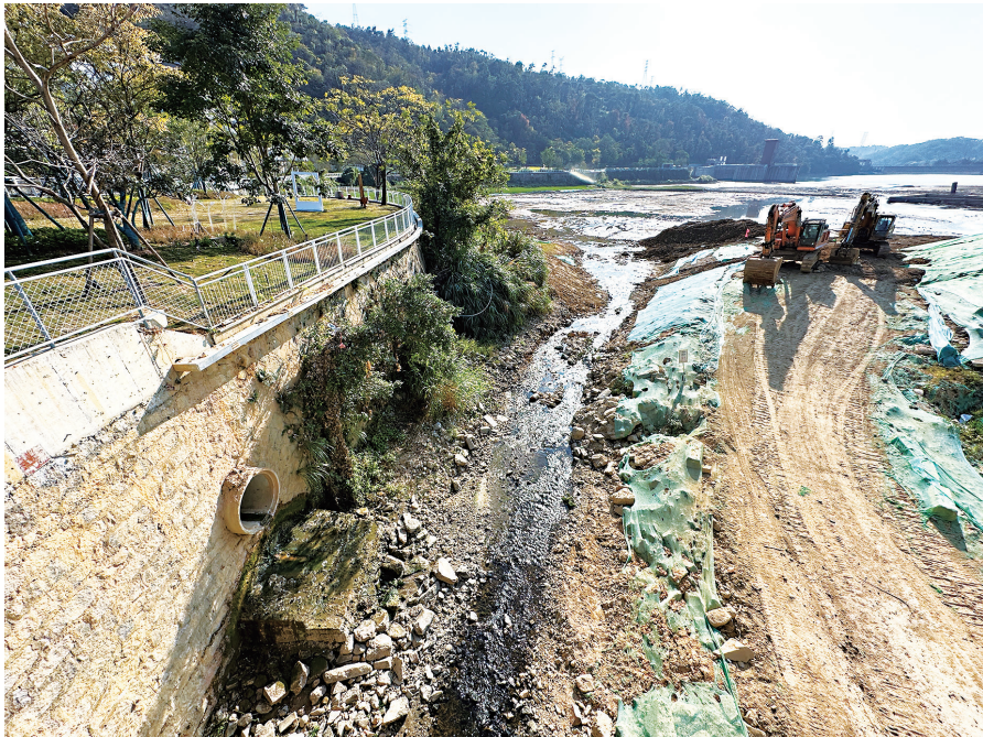
福园养老社区外的排水管向登云水库排水
