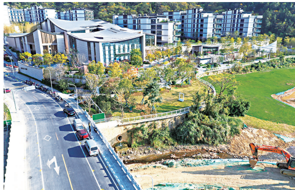
1月2日,记者使用航拍设备拍摄到泰康之家·福园养老社区的雨水管道正在向外流水
