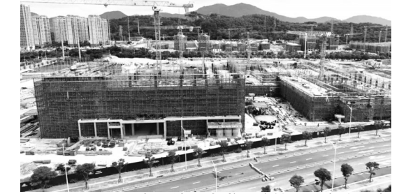
泉州培元中学北峰校区正在建设中
