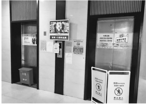
丰泽区奔达明珠小区的电梯,因超龄使用,电梯常出故障
