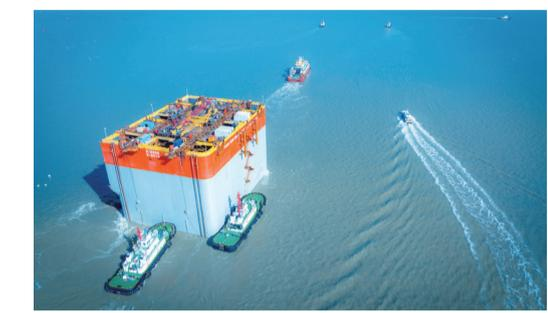
海都讯(记者 杨江参 通讯员 陈珠霞) 1月12日上午,厦金大桥(厦门段)刘五店航道桥西锚碇钢沉井(后井),由5艘大马力拖轮通过浮运拖带的形式由泉州船厂顺利出坞,拖往厦门桥址施工水域(如上图)。至此,厦金大桥(厦门段)四座锚碇钢沉井,已全部在泉州船厂完成组装并顺利出坞拖带至厦门。
