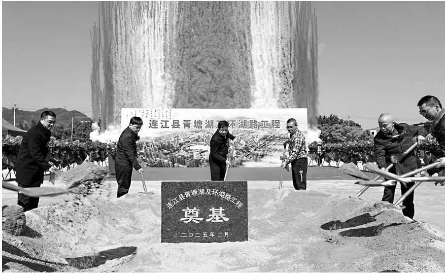
开工仪式现场
