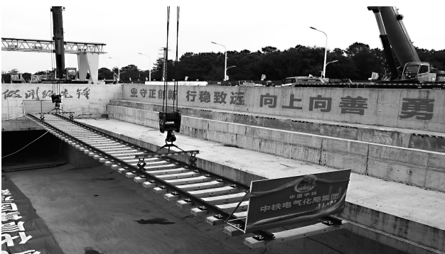
◀地铁6号线东调段全线“洞通”,进入轨道铺设阶段
