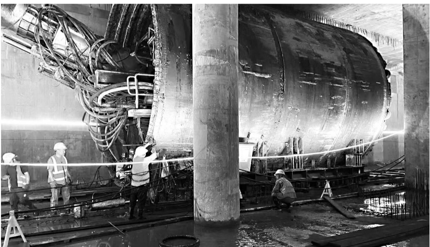
▲10日,6号线东调段滨海中央商务区站至沙尾站盾构区间右线盾构机刀盘破土而出,地铁6号线东调段全线“洞通”
