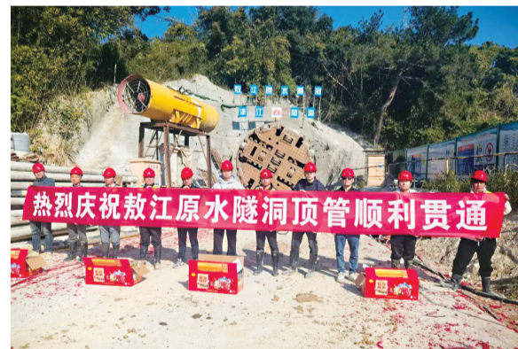
敖江原水隧洞顶管顺利贯通(福州市自来水公司供图)
